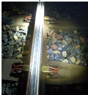
rail après meulage
