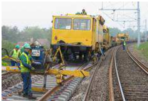
Longs Rails soudés sur traverses béton
