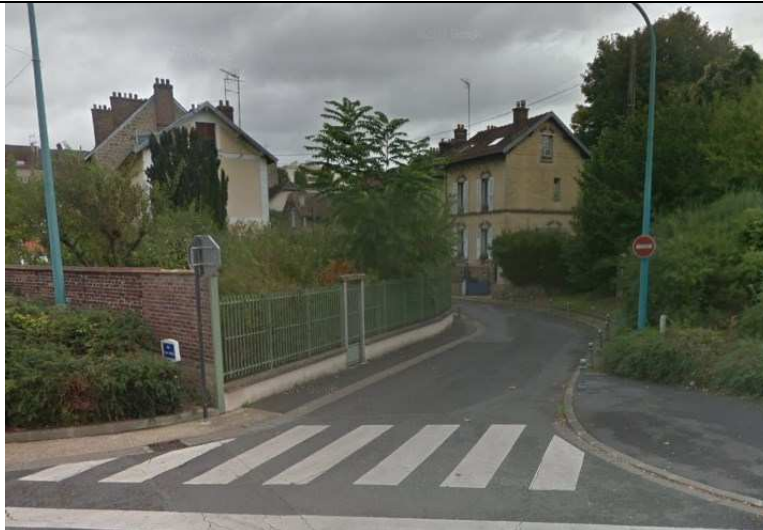
Habitat individuel et collectif + bâti sensible (école Matisse) impactés par la voie ferrée
