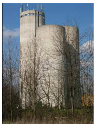
Réservoir d'Osny Marcouville 3000m 3
