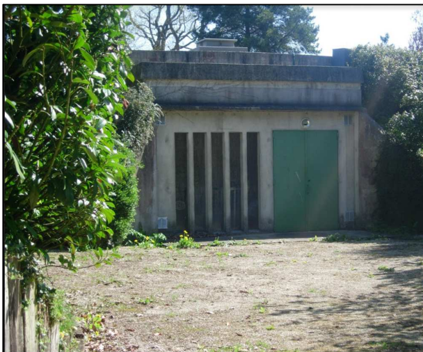
Réservoir de Boisemont 2 x 2000 m 3
