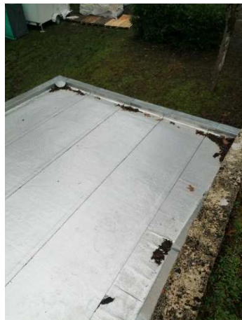
Etanchéité toit terrasse local vanne cuve n°1 Boisemont 2x4000m 3
