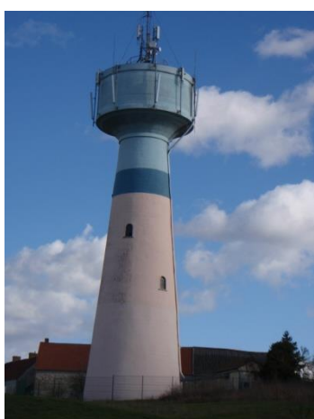
Château d'eau de Courdimanche
