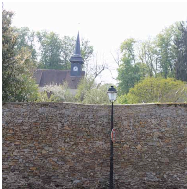
Mur de clôture avec chaperon de pierres en saillie
