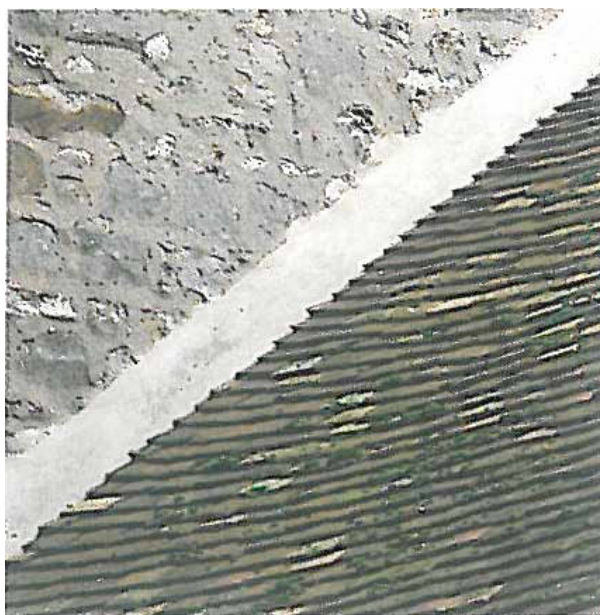
Solin de liaison entre couverture et maçonnerie
