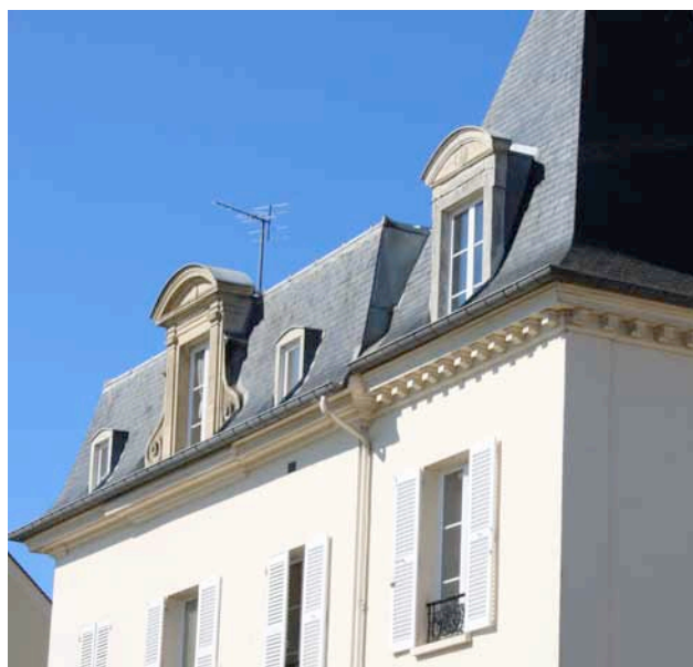
Corniche moulurée en plâtre
