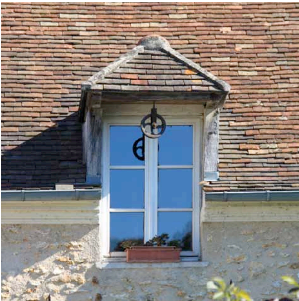
Lucarne "à la capucine" charpentée avec auvent, engagée dans le mur Arêtier en filet de mortier
