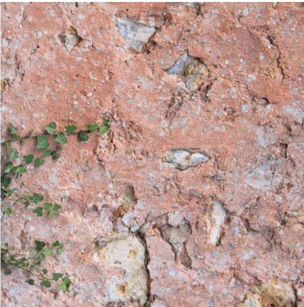
Enduit à pierres vues teinté rose (Ferme Rose)
