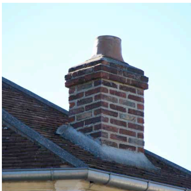
Souche sur versant de toiture ornementée d'un couronnement de briques
