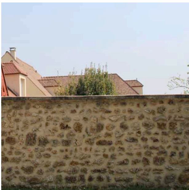
Mur de clôture avec chaperon en saillie
