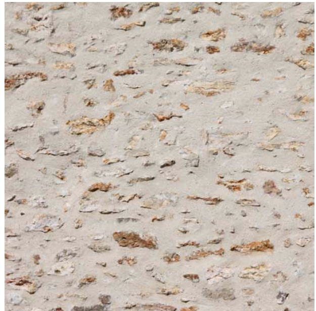
Enduit ravalé à pierres vues ton pierre
