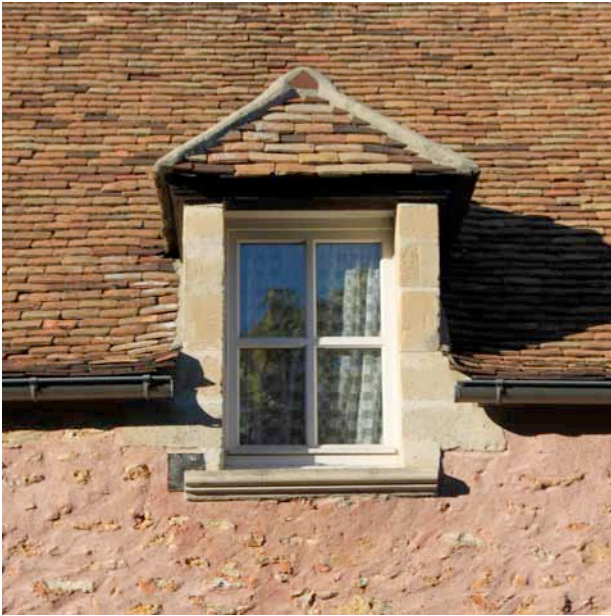
Lucarne "à la capucine" maçonnée engagée dans le mur
