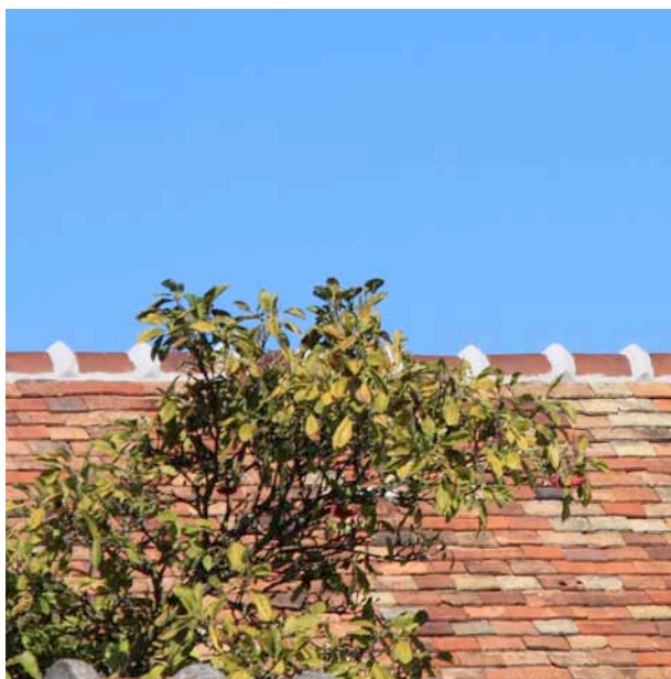
Toiture en petites tuiles plates et faîtières en crêtes de coq
