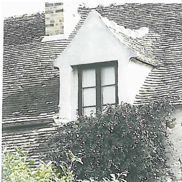
Lucarne sur versant "à fronton" maçonnée
