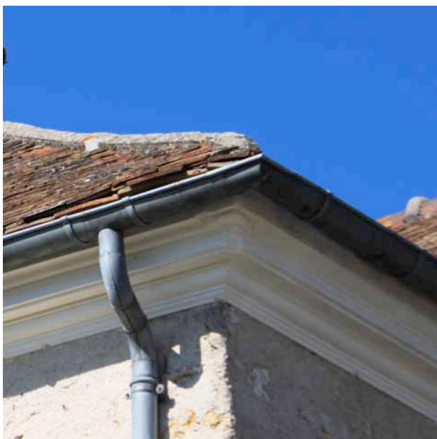
Corniche moulurée en plâtre
