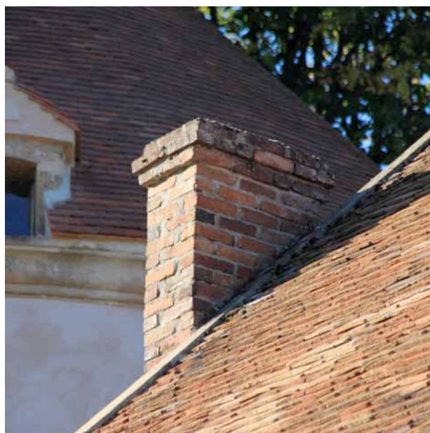
Souche en pignon de toiture ornementée d'un couronnement de briques
