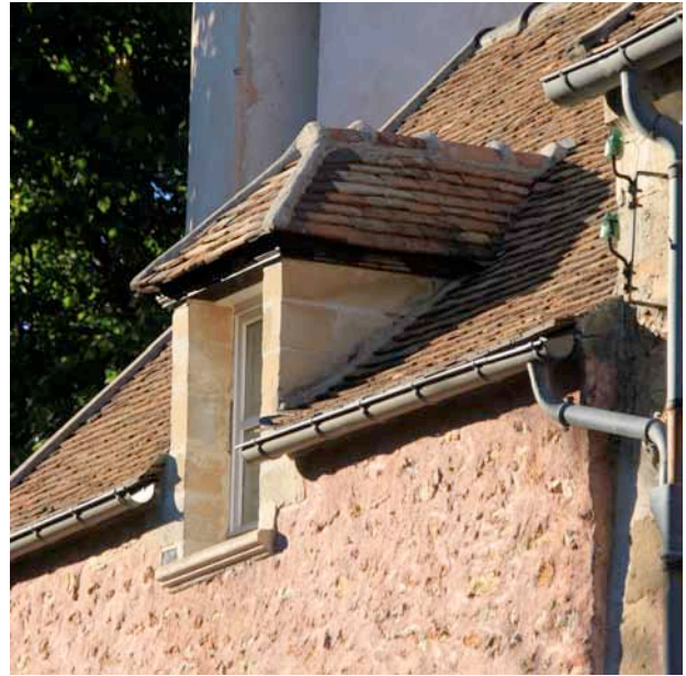
Lucarne "à la capucine" maçonnée engagée dans le mur
