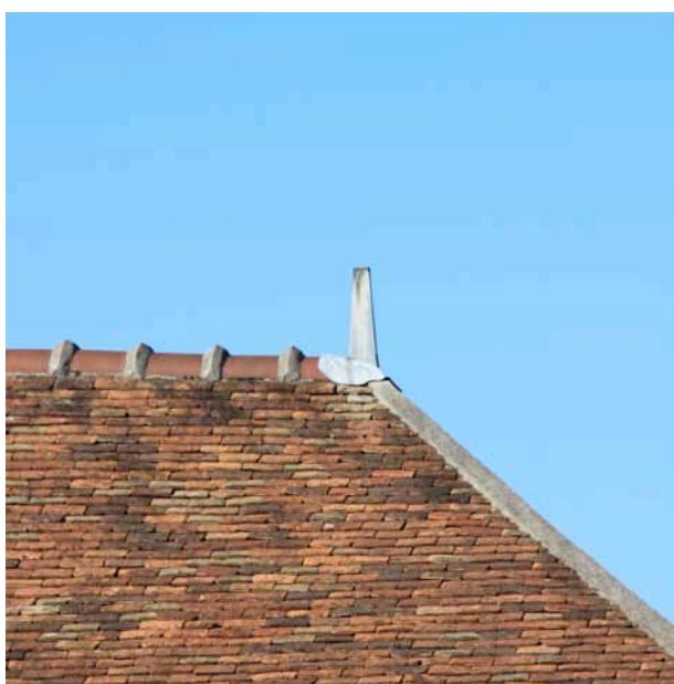
Arêtier scellé au mortier
