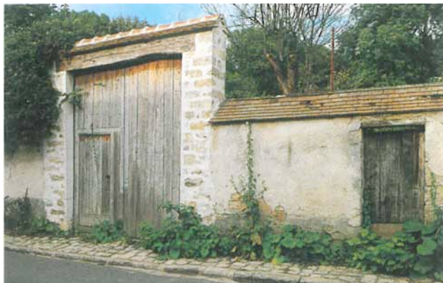
Mur de clôture avec chaperon de tuiles plates Porte piétonne et porte charretière
